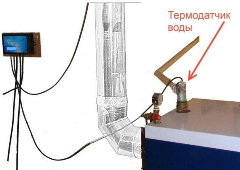
Датчик ВОДЫ должен быть надежно прикреплен к трубе на отопительном котле, по которой выходит горячая вода для отопления дома. Надежное крепление может быть выполнено с помощью алюминиевой клейкой ленты.
