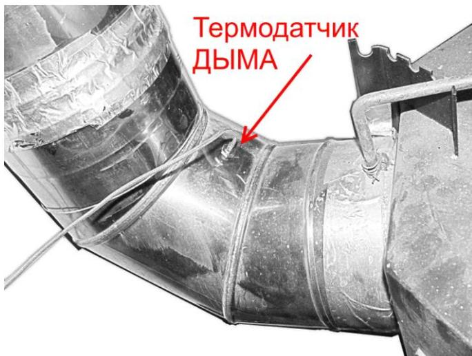
Датчик дыма нужно установить непосредственно в дымоход- как можно ближе к котлу. Датчик ДЫМА вкручивается в отверстие которое нужно просверлить в начале дымохода. При закручивании датчика ДЫМА нужно придерживать провод – что бы он не крутился вместе с болтом. В противном случае провод можно повредить и датчик дыма будет испорчен.
